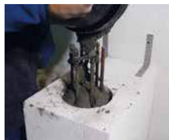
PER IRRIGIDIMENTI BLOCCHI FORATI GASBETON
