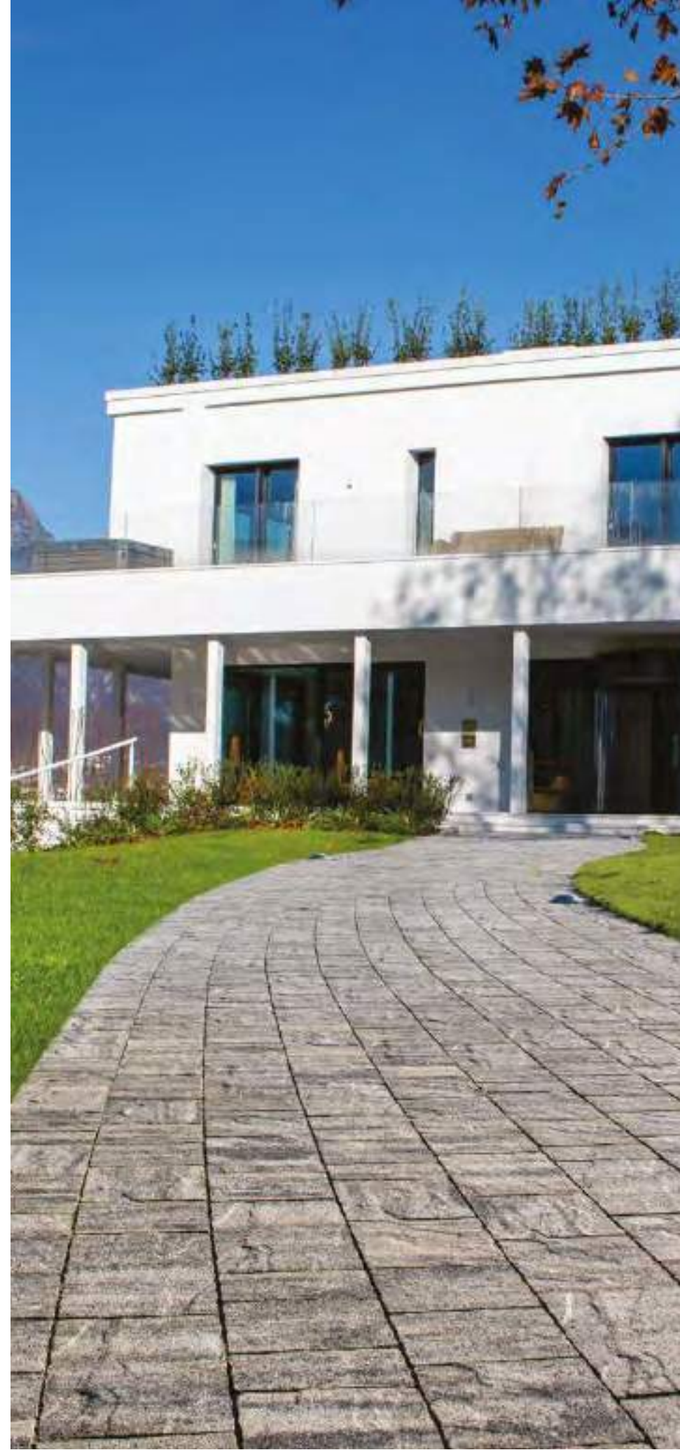
CASSIA DRENOPAV® - SABBIA DI SATURNO
